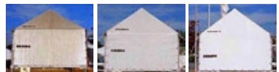
一般膜材      フッ素コート膜材      光触媒コート膜材
